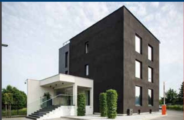
APASmart - BLACK HOUSE, ul. TARNOGÓRSKA 260, 44-105 GLIWICE
